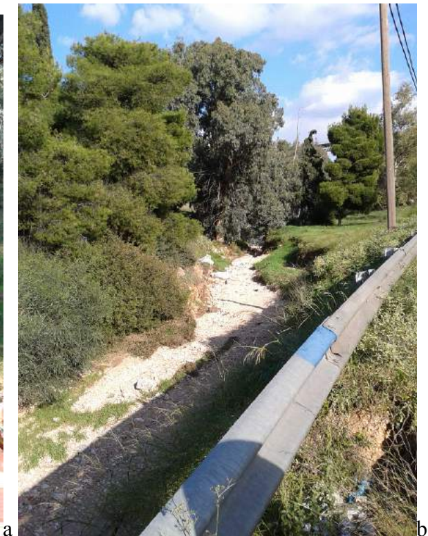
Σημεία 4 – 5: 3 Δεκεμβρίου 2015. Οι δύο φωτογραφίες a και b , δείχνουν την παραμόρφωση της προστατευτικής μπάρας στο ρεύμα προς Ελευσίνα και το φερτό υλικό που έχει καλύψει την κοίτη του ρέματος το οποίο περνάει δεξιά της Εθνικής Οδού.
